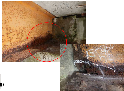
主桁の腐食
