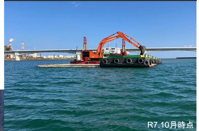
バックホウ浚渫船による河道掘削 (鵜殿・あけぼの地区)
