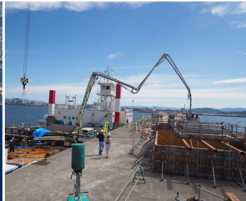
【上部工の嵩上げ状況】
