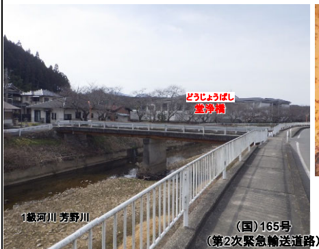
全景(写真①)
