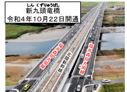
道路と新幹線が下部工を共有する併用橋 令和4年10月22日開通
