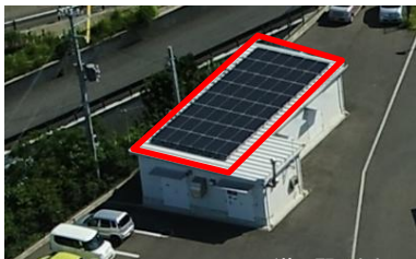
道の駅 すさみ
