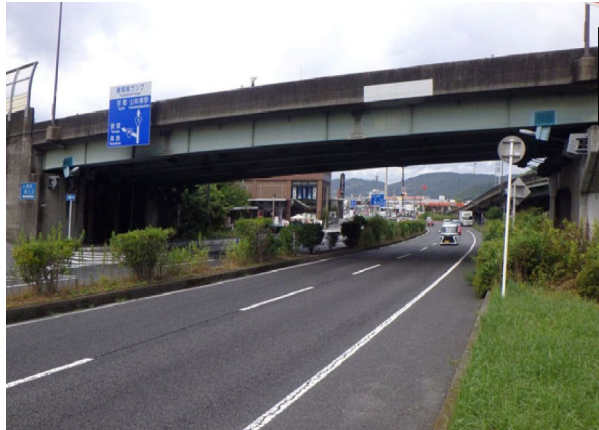
ふじお こうかきょう 藤尾高架橋(全景)
