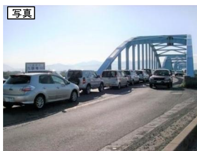
写真 福井丸岡線(九頭竜橋)
