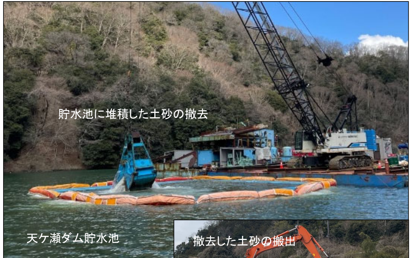
天ヶ瀬ダムの貯水池での浚渫工事の様子
