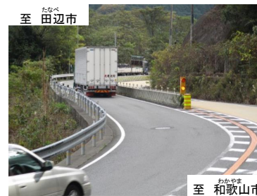
写真③ 平面線形不良箇所
