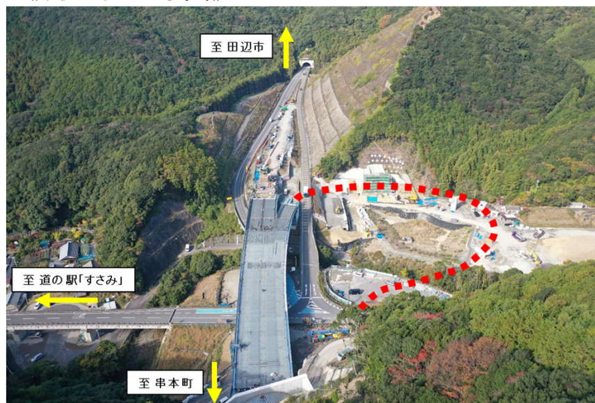
《現地状況写真》
