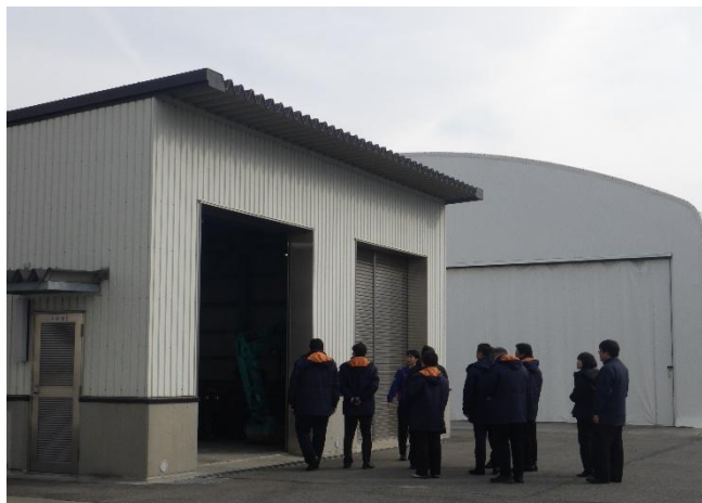
機材説明(車庫棟)
