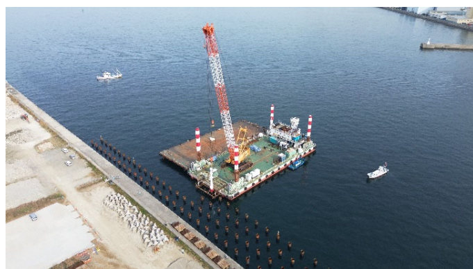
岸壁(-12m)の工事の様子 (油圧ハンマによる杭打ち)
