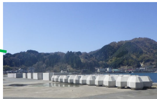
撮影:令和5年3月 ブロック製作状況
