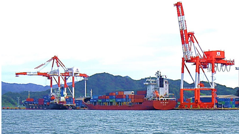
定期コンテナ船の荷役状況(舞鶴国際ふ頭)
