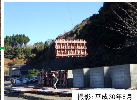
ブロック製作状況
