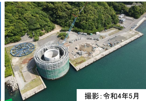
10号函(3-8ロット) 製作状況
