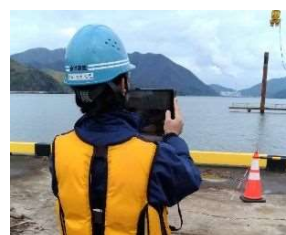
タブレットによる出来形・品質管理
