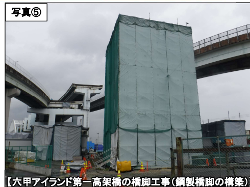
【六甲アイランド第一高架橋の橋脚工事(鋼製橋脚の構築)】
