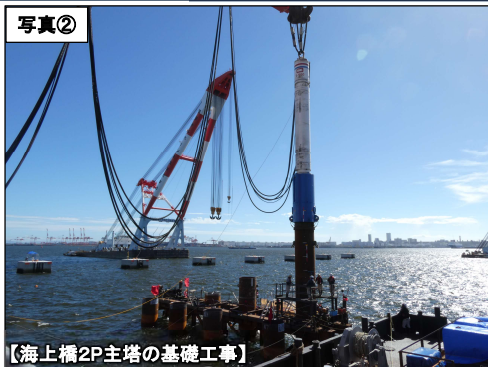
【海上橋2P主塔の基礎工事】
