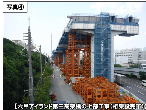
【六甲アイランド第三高架橋の上部工事(桁架設完了)】
