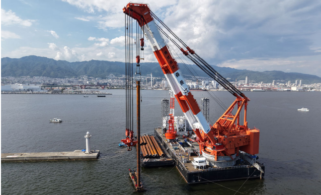
鋼管杭打設全景
