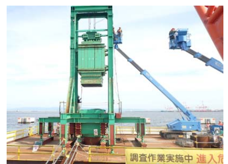
急速載荷試験の実施状況
