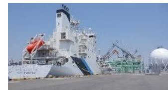
神戸港における液化水素の荷役実証事業
