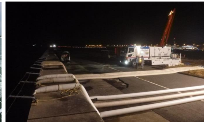
▲照明車による夜間作業支援
