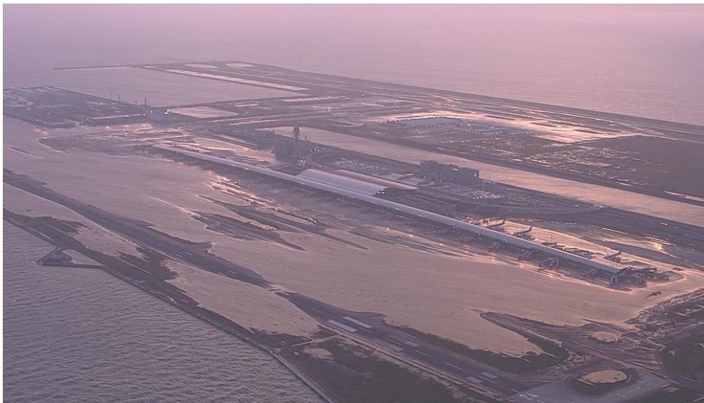
▲関西国際空港冠水状況（9/4撮影）
