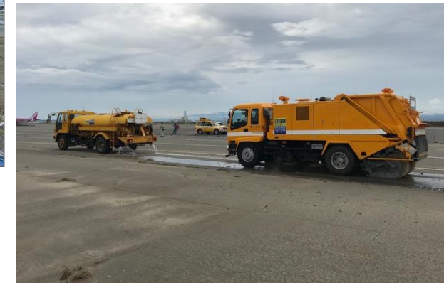
▲道路清掃車、散水車による清掃作業
