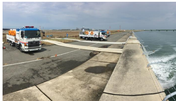
▲排水ポンプ車による緊急排水作業
