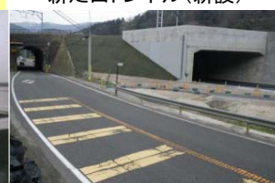
新疋田トンネル(新設)
