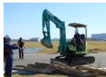
近畿地整職員による道路啓開
