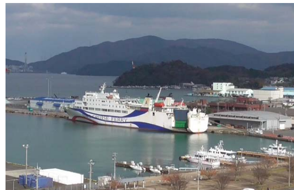
国際フェリー着岸状況
