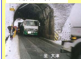
疋田トンネル
