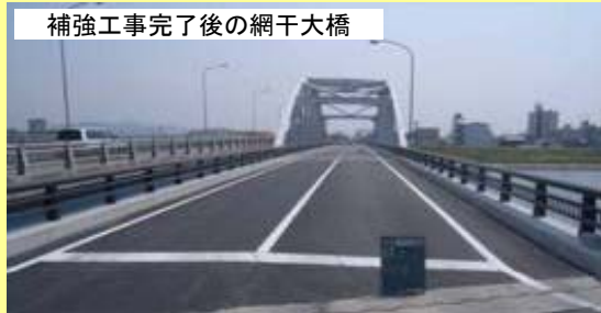
補強工事完了後の網干大橋
