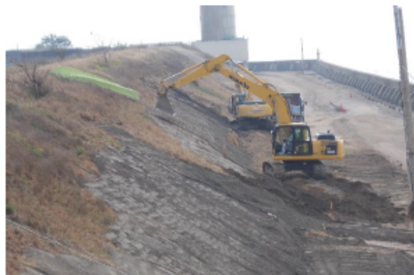
法面の整形作業
