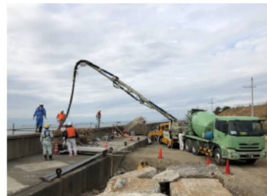
上部工のコンクリート打設作業
