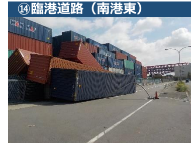
（コンテナ荷崩れによる照明灯破損）
