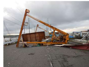
阪南港 木材地区 臨港道路
