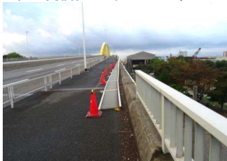
堺泉北港 助松地区 泉大津大橋
