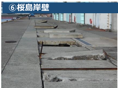
（接続板破損）
