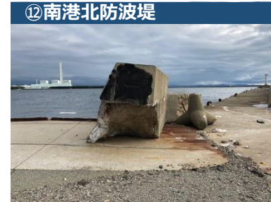
（防波堤破損）
