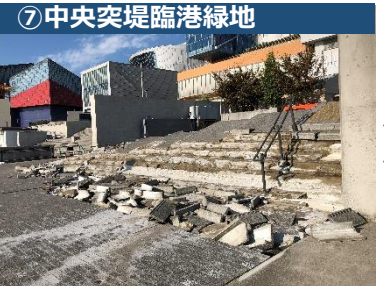
（階段損傷）
