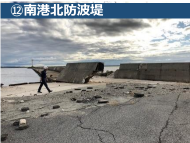
（防波堤破損）
