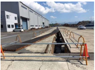
堺泉北港 助松地区 1号2号物揚場
