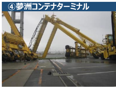
（トランスター破損）
