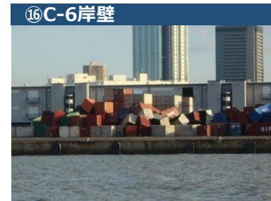
（コンテナ荷崩れ）
