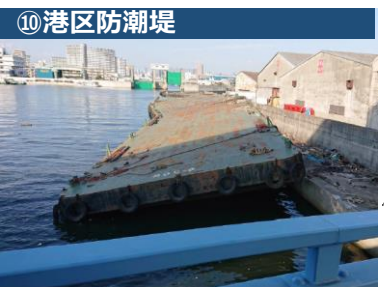
（防潮堤前面への台船乗り揚げ）
