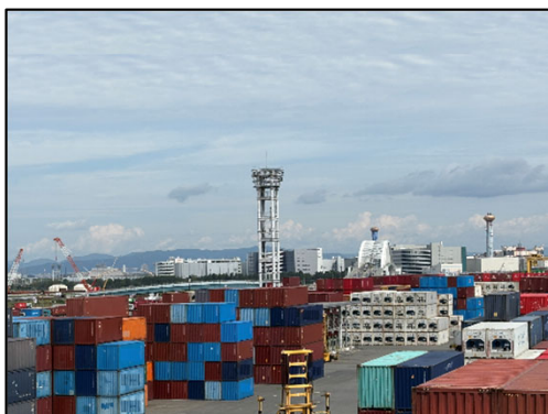
コンテナヤード内 照明塔のLED化
