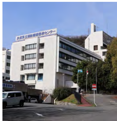
【解体前(病院本館)】
