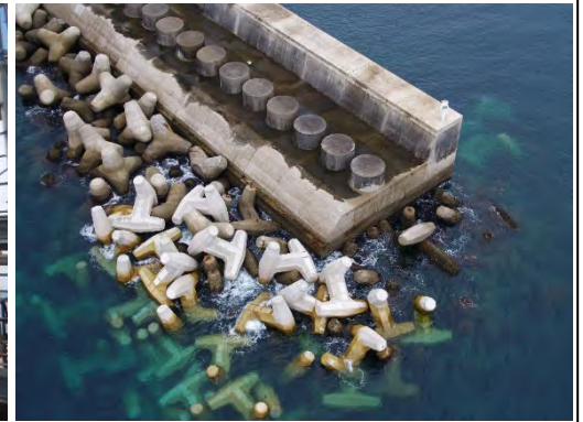
【消波ブロック設置(復旧)状況】
