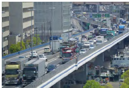
京橋ランプ付近
