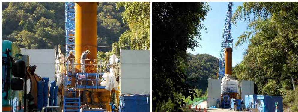
鋼管杭施工状況
