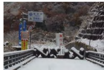
写真① 冬期通行止め写真（滋賀県側）（H29.11）
