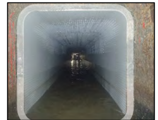
耐震対策後(管更生)
