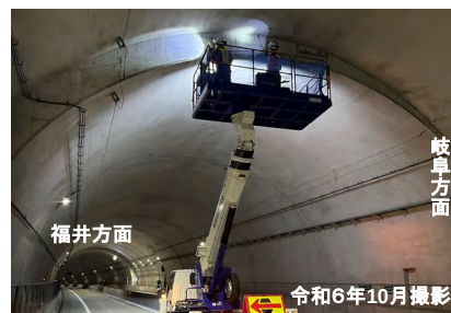
福井県E67中部縦貫自動車道 荒島第1トンネル
