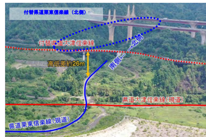
写真①: 付替県道栗東信楽線（北側）
