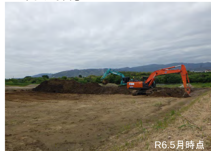
&lt;工事状況写真①&gt;
