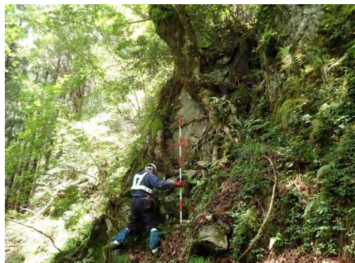
斜面上方の状況(浮石)
