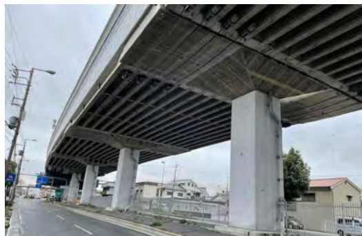
堺市 堺高架橋(全景)
