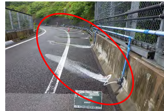
対策イメージ(消雪設備修繕)
