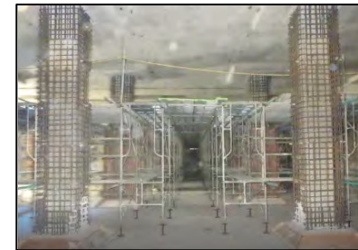
土木躯体の耐震補強
