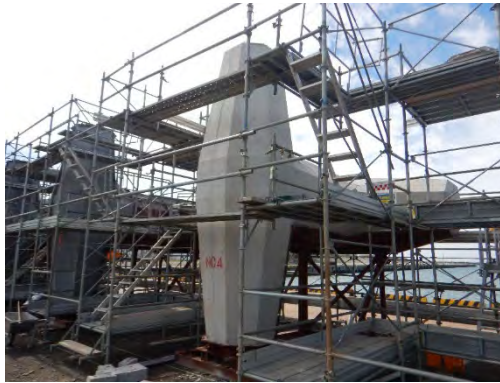
【消波ブロック製作状況】
