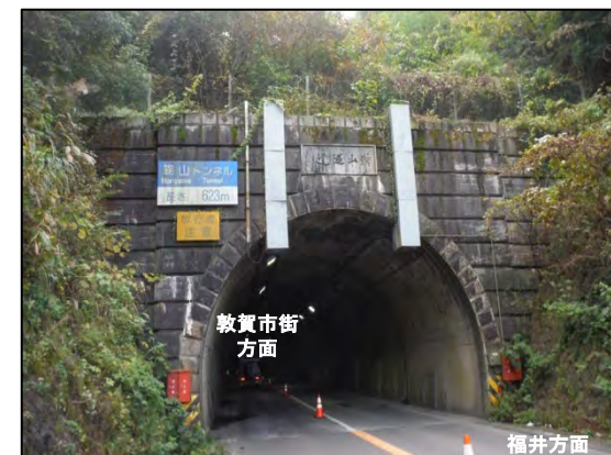
鞠山トンネル(坑口部)
