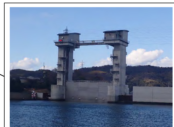
日方水門の閉鎖状況(点検時)
