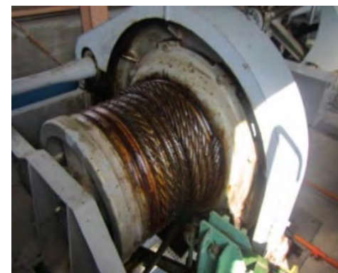
クレストゲート開閉装置改良
