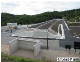
工事状況写真 〈豊岡出石IC橋〉
