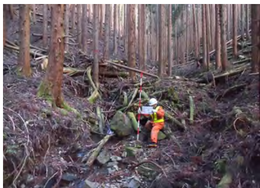
斜面上方の状況(不安定土砂)
