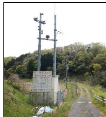
放流警報制御監視設備改良(左: 警報局、右: テレメータ設備)
