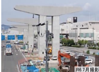
写真① PE2~5橋梁下部工
