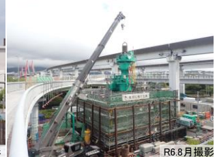
写真② PPE-7下部工
