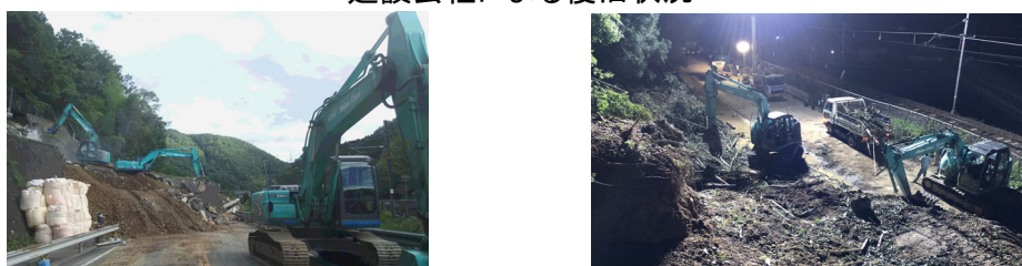
建設会社による復旧状況
