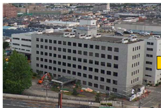
高槻市内ビル除却前
