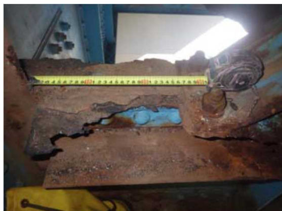
横桁の腐食
