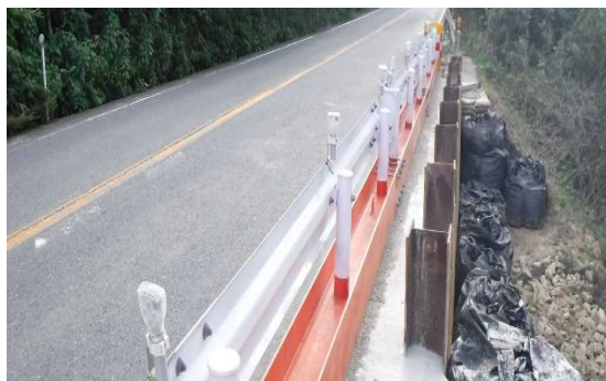
応急復旧状況
