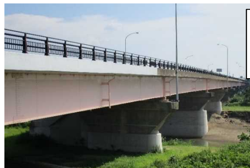
木津川大橋(全景)
