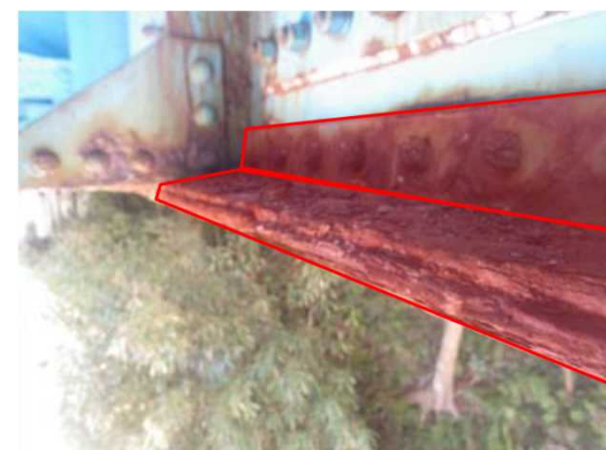
対策イメージ(あて板補修+塗装)
