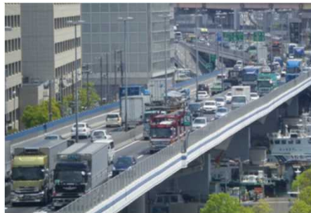
H25.12撮影 京橋ランプ付近
