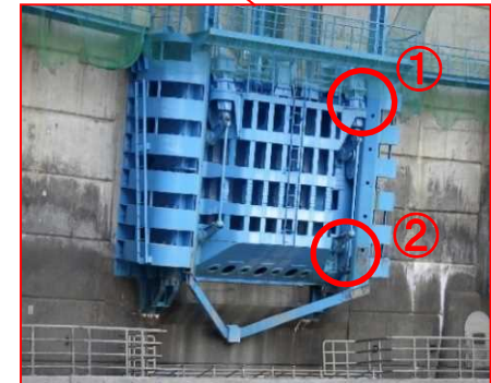
<現状>放流ゲートの老朽化状況
