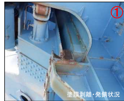
<現状>放流ゲートの老朽化状況
