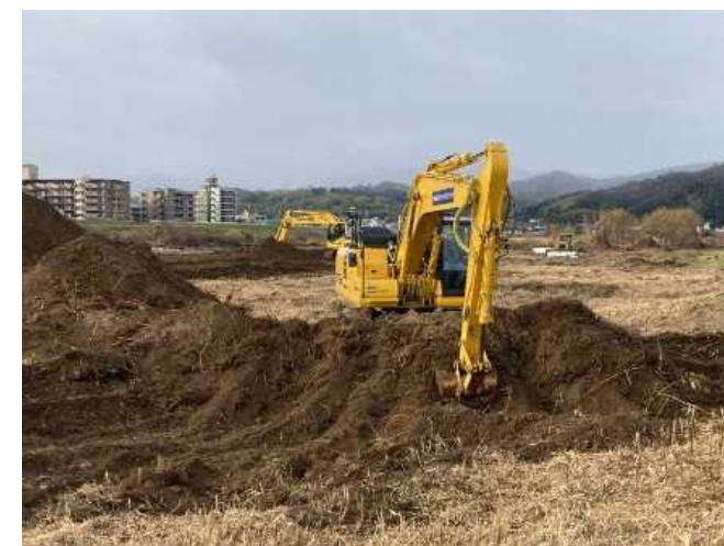
桂上野地区 河道掘削状況
