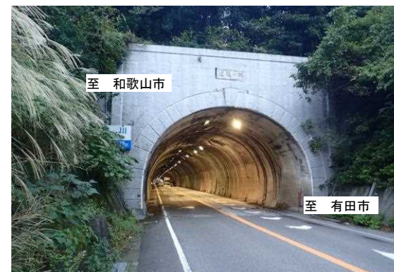
鱒川トンネル(全景)
