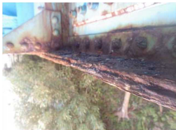
主桁の腐食
