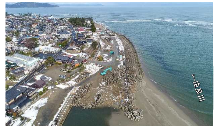
由良・石浦地区 堤防整備状況
