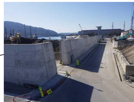
護岸の整備状況
