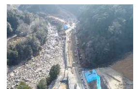
左岸下流施工状況 (R3. 2)
