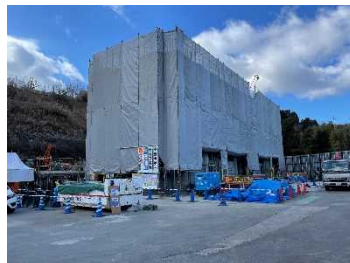
ゲート室部施工状況 (R3. 2)
