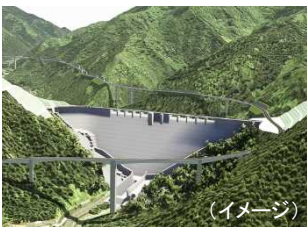
足羽川ダム建設
