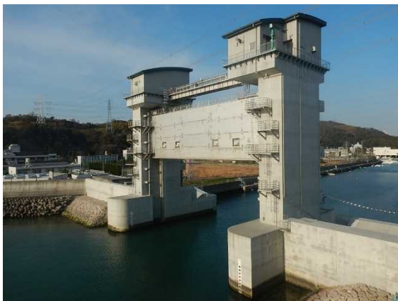
琴ノ浦水門の完成状況
