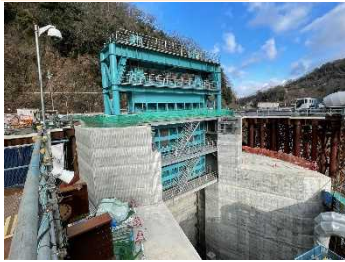
流入部施工状況 (R3. 2)
