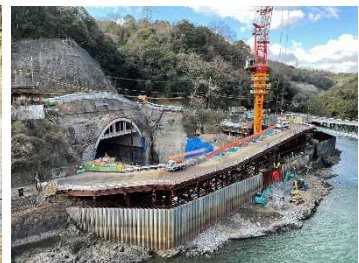
吐口部施工状況 (R3. 2)
