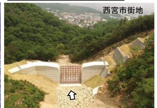
六甲山系 剣谷第四砂防堰堤(西宮市)
