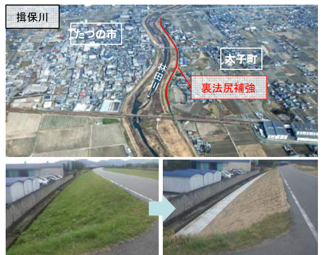
堤防裏法尻の補強整備事例
