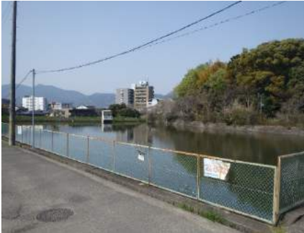
▲平成30年度 新規事業箇所 橋詰池(奈良県香芝市)
