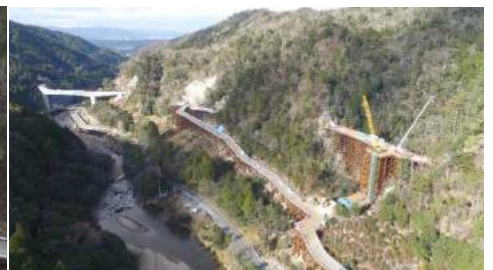
大津信楽線 新6号橋下部施工状況（平成30年1月）
