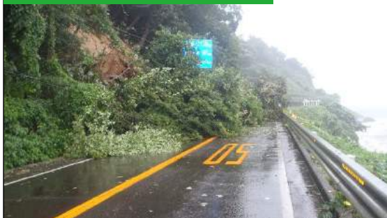
写真①:国道8号敦賀市杉津
