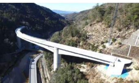
大津信楽線 新3号橋上部施工状況（平成30年1月）
