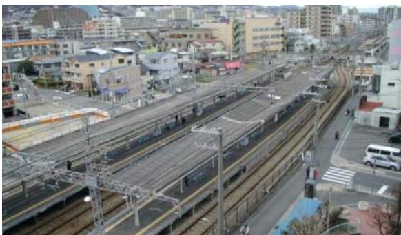
整備前(青木駅付近 平成14年撮影)
