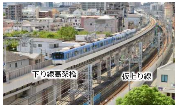
整備中(下り線高架化)(青木～深江駅間 平成29年撮影)
