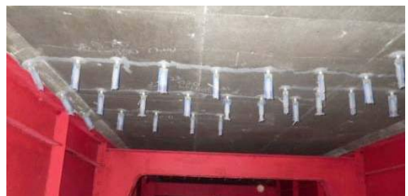
床版のひび割れ注入状況
