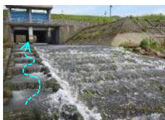
整備後の魚道
