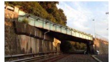
泉跨線橋の現況(全景)
