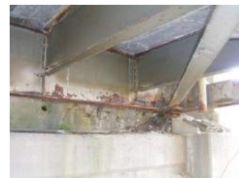
布施田橋の現況 (下部工)
