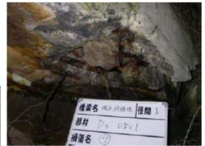
鳩原跨線橋の現況(床版)
