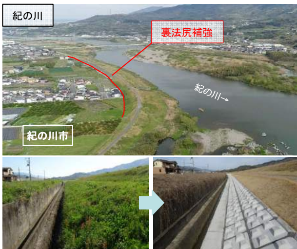
堤防裏法尻の補強整備事例
