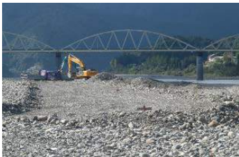
河道掘削：熊野川（和歌山県）
