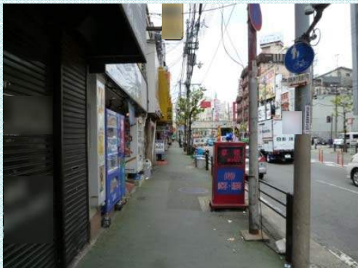
整備前（国道1号京橋駅付近）
