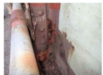
泉跨線橋の現況(主桁)
