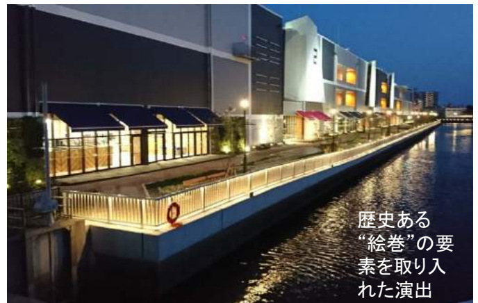
兵庫運河の夜間景観
