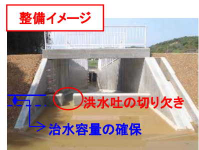
▲洪水吐切り欠きの設置により 治水利用を行った事例
