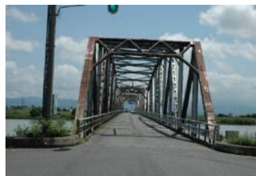
布施田橋の現況 (上部工)
