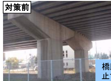
福井県 27号 野神高架橋
