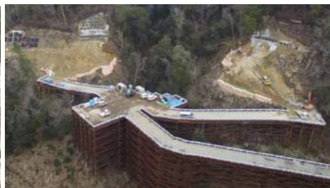
大津信楽線 新5号橋下部施工状況（平成30年1月）
