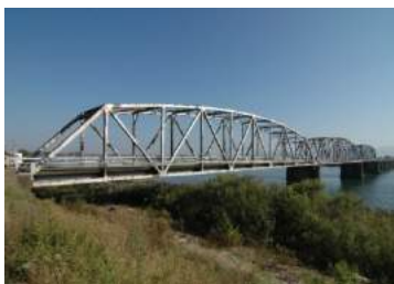
布施田橋の現況 (上部工)
