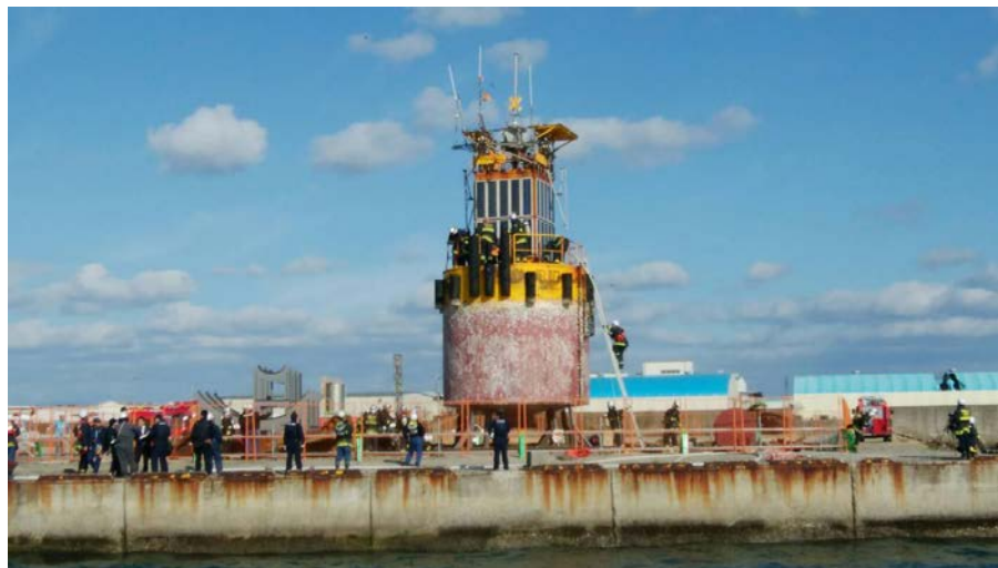
事故発生後の現場状況
