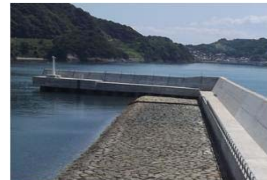
船尾側津波防波堤 (新設部)
