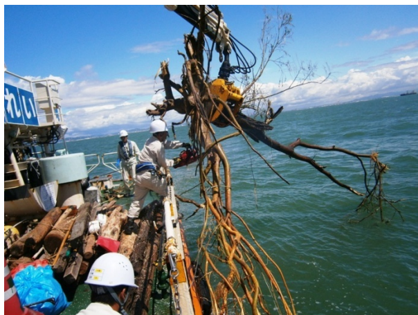
流木回収状況
