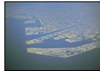
尼崎沖埋立処分場
