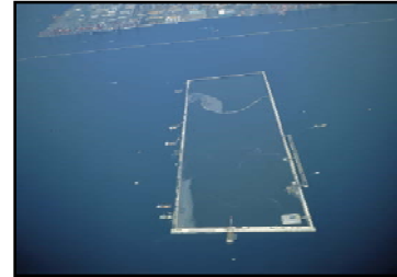
神戸沖埋立処分場
