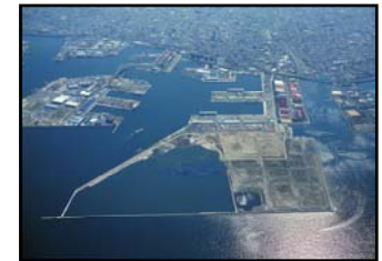
泉大津沖埋立処分場
