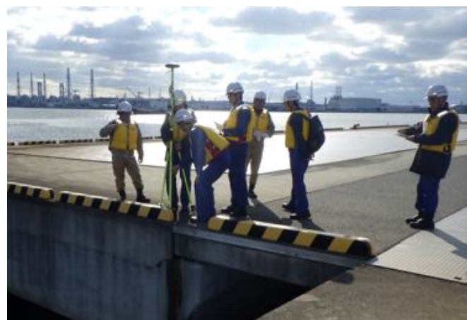
係留施設利用可否判断(地震時変形量調査)
