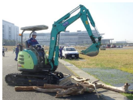
道路啓開訓練(震災がれき撤去) (近畿地方整備局職員によるバックホウ操作)
