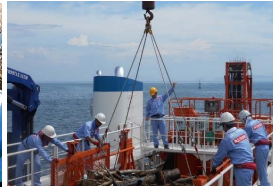
ゴミ陸揚げ状況
