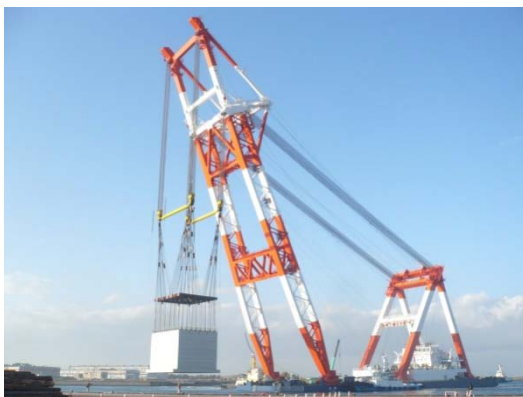
ケーソン吊上げ：西浜ヤード
