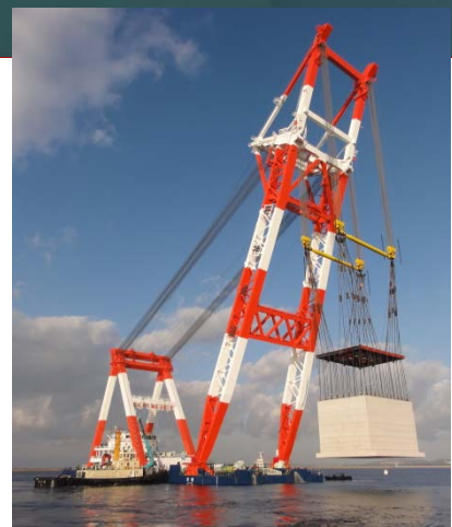
ケーソン据付
