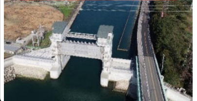
船尾側護岸(改良) 完成
