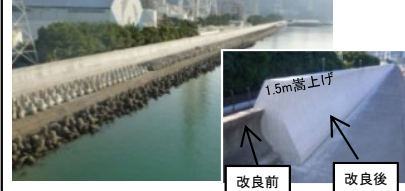
船尾側津波防波堤(新設・改良) 概成
