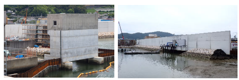
内海水門 内海護岸 整備中
