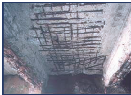
鉄筋の腐食によるコンクリートの剥離
