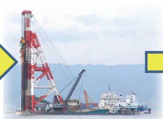
②海上地盤改良
