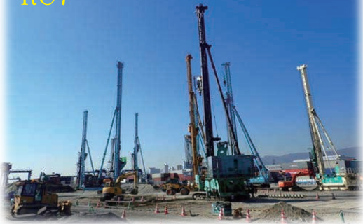
荷さばき地耐震改良(SCP工法) (神戸港)
