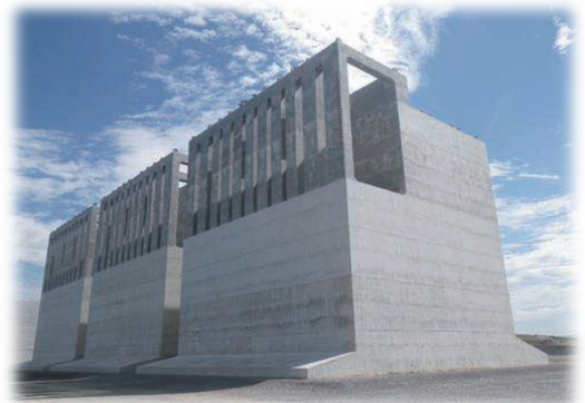
防波堤整備(ハイブリットケーソン製作) (和歌山下津港)
