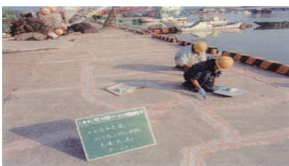
▲ エプロンのひび割れに樹脂を充填
