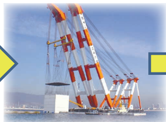
③ケーソン据付
