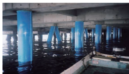
▲ 表面被覆工法による補修
