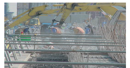
▲ 床版の打ち替え
