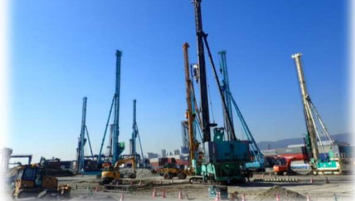
荷さばき地耐震改良事業(液状化対策) (神戸港)
