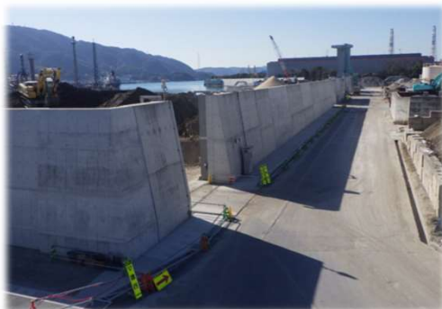
護岸整備状況
