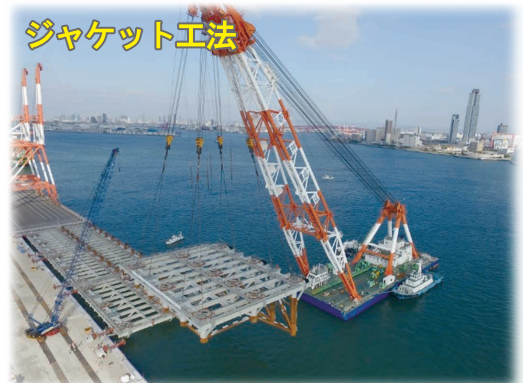
ジャケット工法 耐震強化岸壁整備事業 （大阪港）
