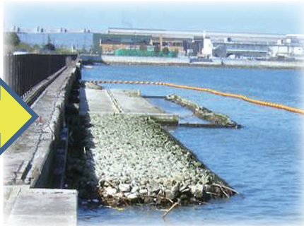
緩傾斜護岸、魚礁ブロックタイプ護岸などを整備して、生物生息環境を改善します
