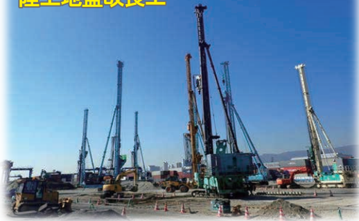
荷さばき地耐震改良事業（液状化対策） （神戸港）
