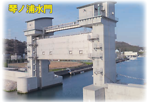
津波対策事業（水門の整備） （和歌山下津港）
