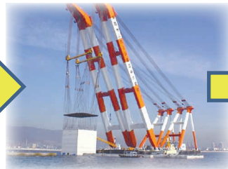
③ケーソン据付
