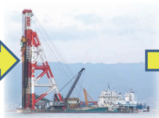
②海上地盤改良
