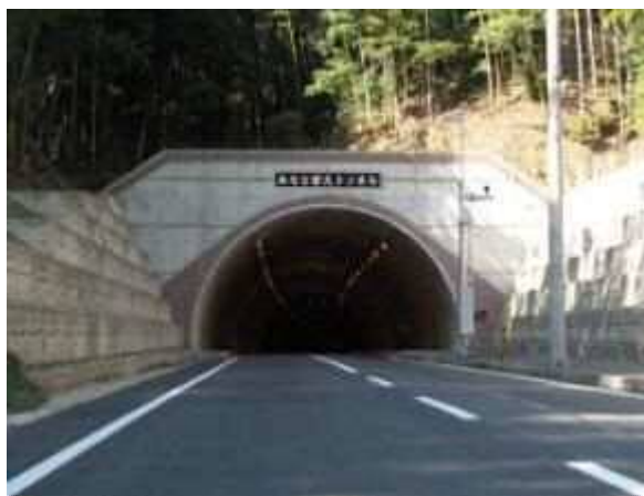
みなと安久トンネル
