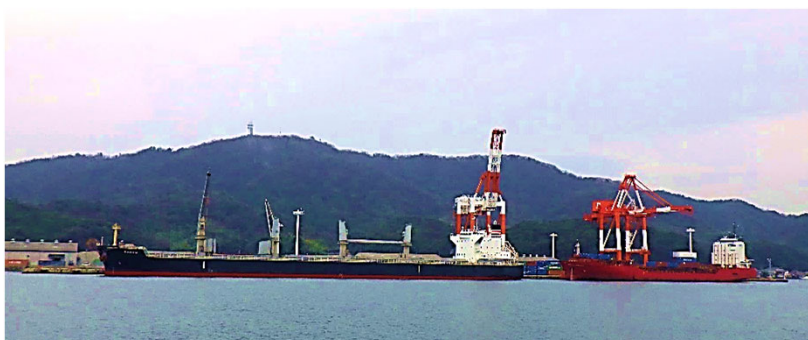
コンテナ船とバルク船の2隻同時着岸状況
