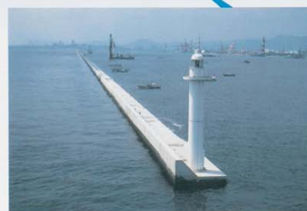
●防波堤 (第7) 東側
