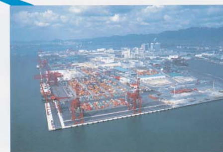
●六甲アイランド地区：緊急コンテナ(仮設)棧橋埠頭
