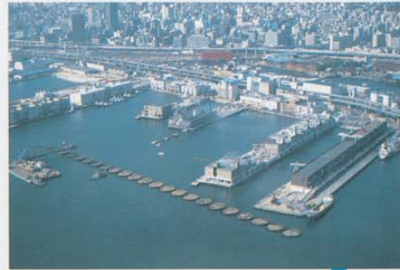
●新港東地区：岸壁 (-12m)
