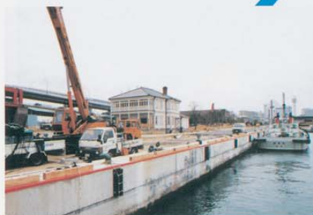
●ポートアイランド地区：-4m物揚場② (北公園)
