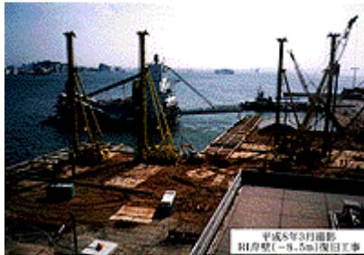
本施設は、六甲アイランドのフェリーバースとして利用されてます。復旧は、隣のフェリーバース(RF2)との並びからケーソンの据直し工法を採用しています。耐震強化岸壁とするため、岸壁背後の土圧を大幅に低減する必要から、事前混合処理工法(セメント処理土)により岸壁背後の裏埋を行い、さらに表層には水破スラグを使用することにより土圧を低減しています。また、振動締固めによりケーソン下部の置換砂の改良も行います。
