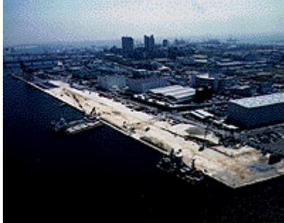
復旧は、現施設をそのまま再利用し、岸壁背後の裏込石及び裏埋土を掘削し、事前混合処理土（セメントと裏埋土砂を混合）によって埋戻しを行い、土圧低減にする方法を採用しました。
