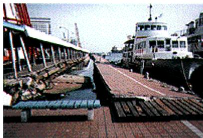
重力式岸壁では、法線の全面せり出し(1～5m)、天端高の沈下(1～2.5m)が生じており、新港突堤と兵庫突堤では突堤先端部の崩壊・水没が起きました。しかし、摩耶埠頭の耐震強化岸壁の被害は極めて軽微な範囲にとどまりました。
