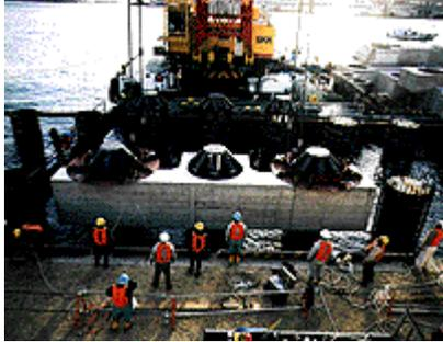
復旧は、スリップ内であることから前面の水域に制約を受けること、背後に上屋が接近していることから、既設のケーソンの前面に鋼管杭を打設し、コンクリートブロックを杭にはめ込んで締結させ、裏込石を投入し上部工を打設するPBS工法としました。
