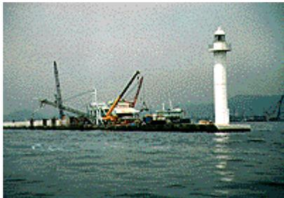
防波堤では、法線の変位は比較的小さな範囲内でしたが、天端高が1～2.5m沈下し、防波堤機能が著しく低下しました。
