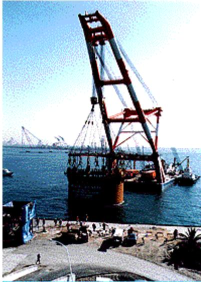
本施設は、埠頭機能が低下した新港東(新港第5突堤～第8突堤間)地区間を埋め立て、南側前面に新たに大型岸壁を建設する一部であり、第6突堤～第8突堤間の580m区間に根入れ鋼板セルが採用されました。この岸壁は、耐震強化岸壁として位置づけられています。
