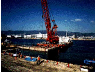
トランパーバースとして利用されています。復旧は、スリップ内であることから前面の水域には制約を受けるが、岸壁背後にスペースがあったことから、ケーソンの据え直し工法を採用しています。背後は、液状化対策を行います。
