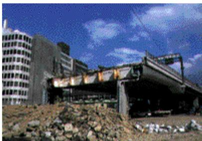
神戸市営地下鉄では中柱や高架橋の破損、JR西日本、阪神電鉄、阪急電鉄、神戸高速鉄道、神戸電鉄、山陽電鉄でも駅舎の破損、高架橋の桁落下等の被害を被り運行停止状態となりました。阪神高速道路では橋脚の倒壊、橋桁落下等がありました。
