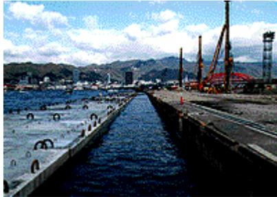
神戸港埠頭公社のコンテナバースとして使用されています。復旧は、工期の短縮を最重要視し、既設ケーソンの前面にケーソンを設置して、このケーソン間をPCホロー桁で連結するデタッチドケーソン構造としました。このケーソン間に間詰石を投入することで、既設ケーソンの安定を保っています。既設ケーソンの背後は、液状化対策をするとともに表層部には水砕スラグを用いて土圧低減を図っています。この工法は、六甲アイランドのコンテナバース等の復旧にも採用しています。
