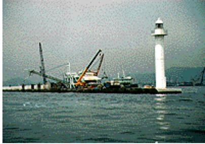
防波堤の法線の変位はあまりみられませんでした。全延長にわたって沈下しており、最大2.5m程度の沈下量が生じていました。市街地を津波等から守る防波堤は、台風期までに早期の機能回復を目指し、復旧は上部工の嵩上げと捨石等の投入(第1は港内外、第6と第7は港内側)で対応しました。
