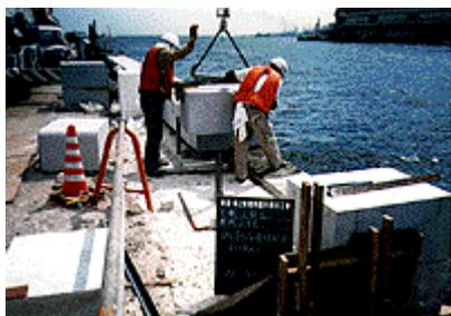
第2突堤は、大正時代に築造されたものであり、上部工は御影石で積まれており歴史的な重要な施設となっております。復旧はスリップ内であることから前出し量の制約を受けること、上屋が接近していることから、既設の上部工を撤去後にコンクリートで嵩上げし、御影石で上部工を積み上げる工法としました。(注) スリップ(slip)とは突堤間の水面のこと
