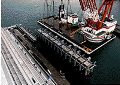
中突堤は、旅客用バースとして使用されており、突端先端にはホテルがあります。復旧は、岸壁背後にホテルがあること、前面水域が狭いこと、旅客ターミナルの早期運営の必要があること、対岸の高浜棧橋の復旧工事との関係から、工期短縮に重点をおいたジャケット式構造物を採用した工法としました。
