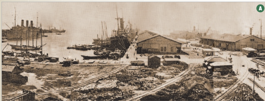
第1期修築工事中の小野浜。引き込み線ができつつあり、港を利用する船が見えます
