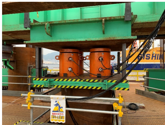
▲載荷ジャッキ
