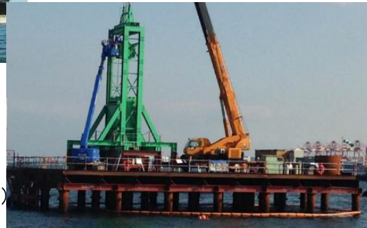
図-2. 国内最大規模の急速載荷試験 (東京港新客船ふ頭: 鋼管杭径2,000mm)
