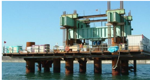
図-1. 国内最大規模の静的載荷試験 (東京ゲートブリッジ: 鋼管杭径1,500mm)
