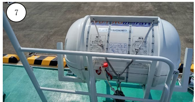
写真9 救命筏の設置
