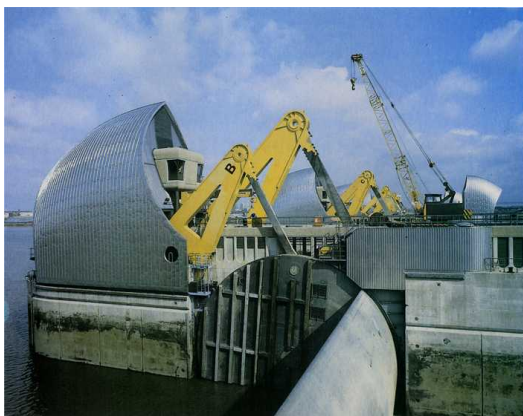
図-7 上昇式セクターゲート（テムズバリア）
