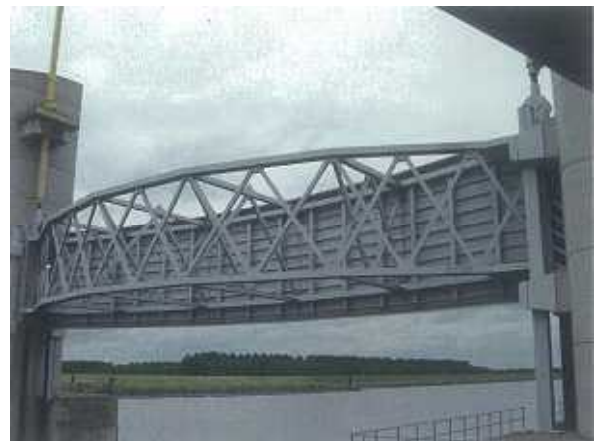
図-9 ローラーゲート（ハーテル防潮ゲート）
