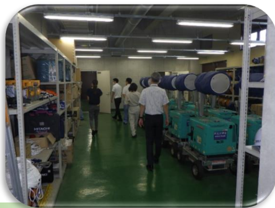
支援施設棟の保管庫を見学
