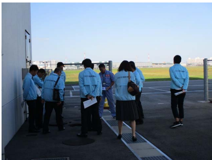
防災センター内の汚水槽設備確認
