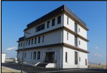
近畿圏臨海防災センター
