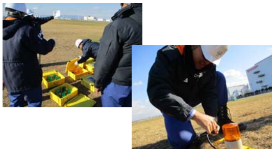
緑地班による夜間灯火設置
