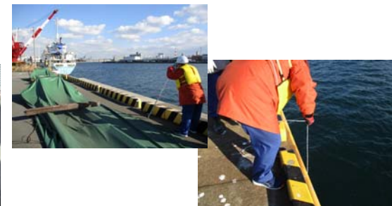
岸壁班による計測
