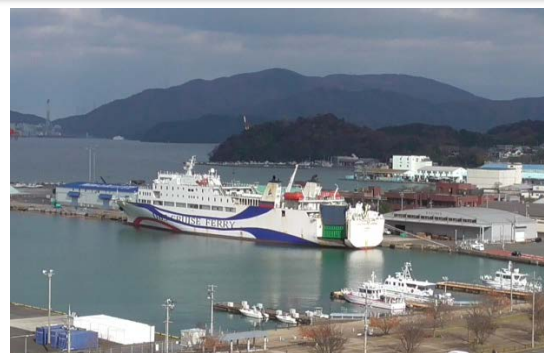
国際フェリー着岸状況
