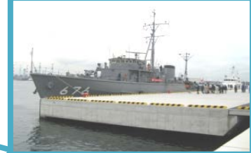
耐震強化岸壁 水深-7.5m 延長130m (平成23年度供用)
