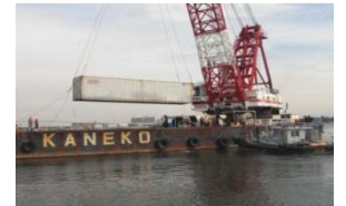
緊急確保航路内にコンテナ が流出した想定での啓開 (コンテナ回収)
