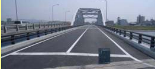
補強工事完了後の網干大橋
