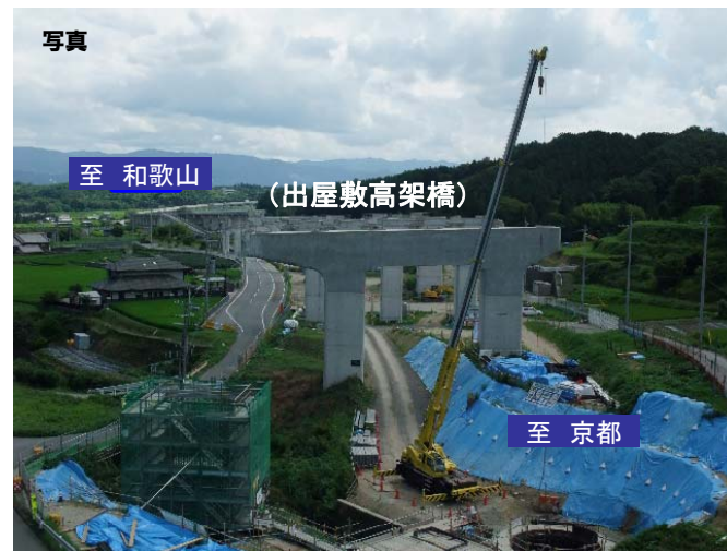
写真 至和歌山 (出屋敷高架橋) 至京都 <大和御所道路>
