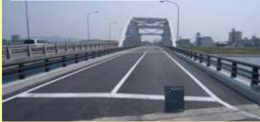
補強工事完了後の網干大橋
